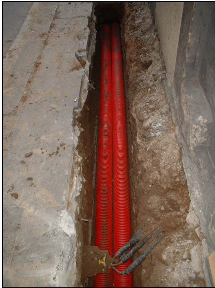
Fotografia 4: Col·locació del cablejat elèctric.
